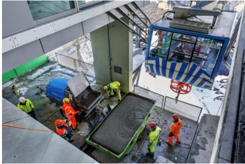
Bildlegende: Betontransport Gipfel
