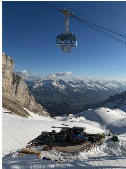
Bildlegende: Materialtransport Stütze 2 ©Mera Film AG
