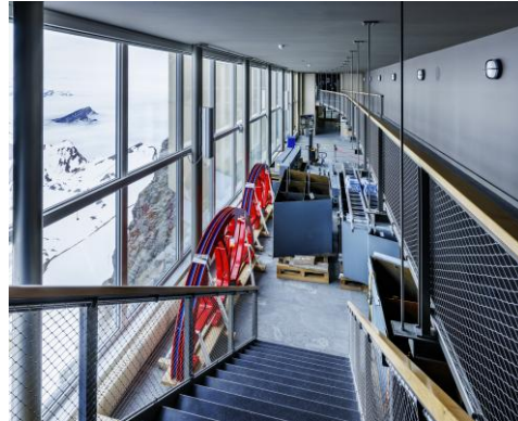
Bildlegende: Baumaterial Panoramahalle Gipfel
