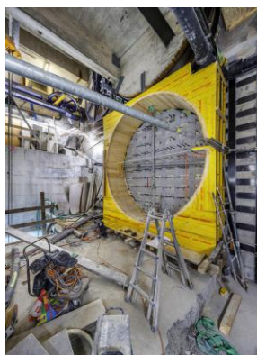
Bildlegende: Betonschalung Tragseilpoller auf dem Gipfel
