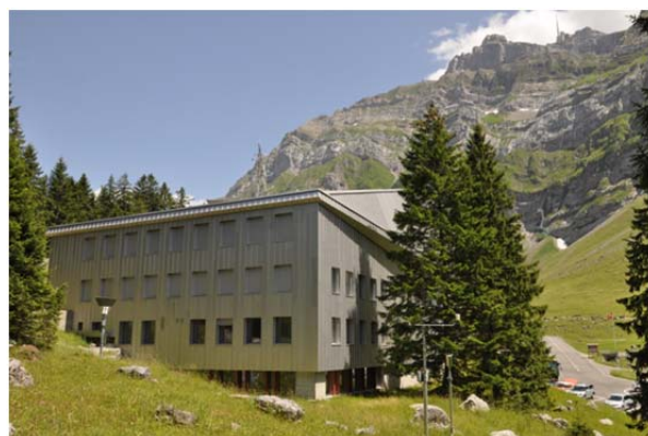
Die moderne Metallfassade, inklusive des Daches, der Schwebebahnstation vermittelt ein technisches Aussehen.
