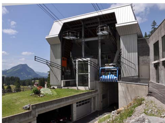
Der neu erstellte Warenlift am Kopf des Perrons sowie die Anlieferungs- und Entsorgungsräume im Untergeschoss der Talstation. Lediglich noch ein Notausgang führt direkt ins Freie.
