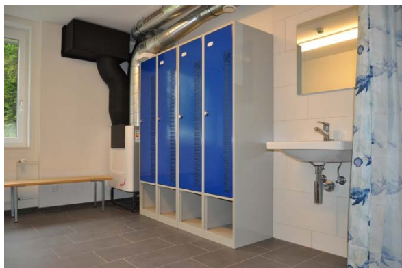
Die neue Damengarderobe inkl. Dusche und Toilette
