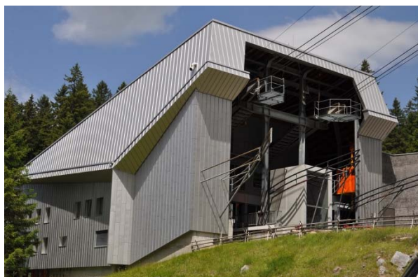
Die Gestaltung der «neuen» Talstation der Säntis-Schwebebahn ist modern und technisch.
