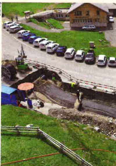
Die Erdsonden sollen zwei Drittel der benötigten Wärme liefern.
