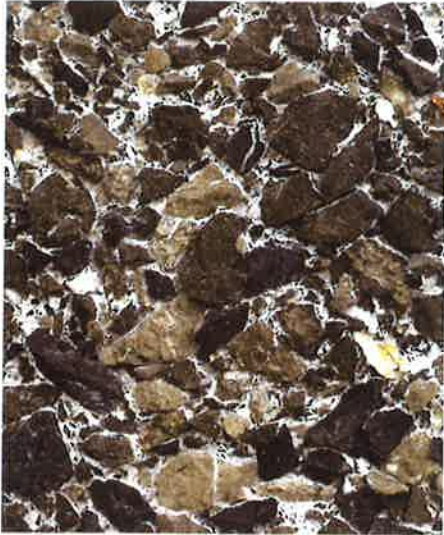
Das Jetting-Verfahren macht den Sântis-Kalkstein wieder sichtbar.
